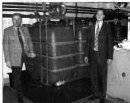
Die Regenwasseranlage zur Spülung der Anlagen, die Produktentwickler Frank Schulte und Marco Lohmann vor der Verkaufsförderung hier zeigen, wurde schon vor sehr langem gebaut. Foto: W.
